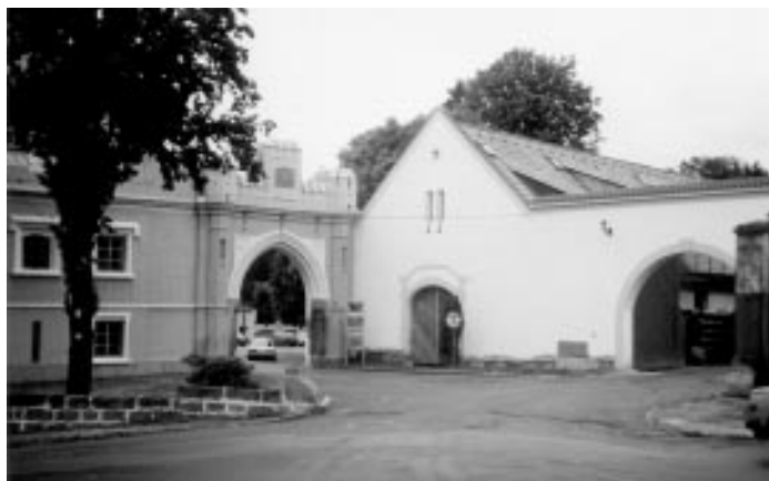
Štít a bránu hospodářských budov u zámku ve Vrchotových Janovicích opravila firma Monou.
